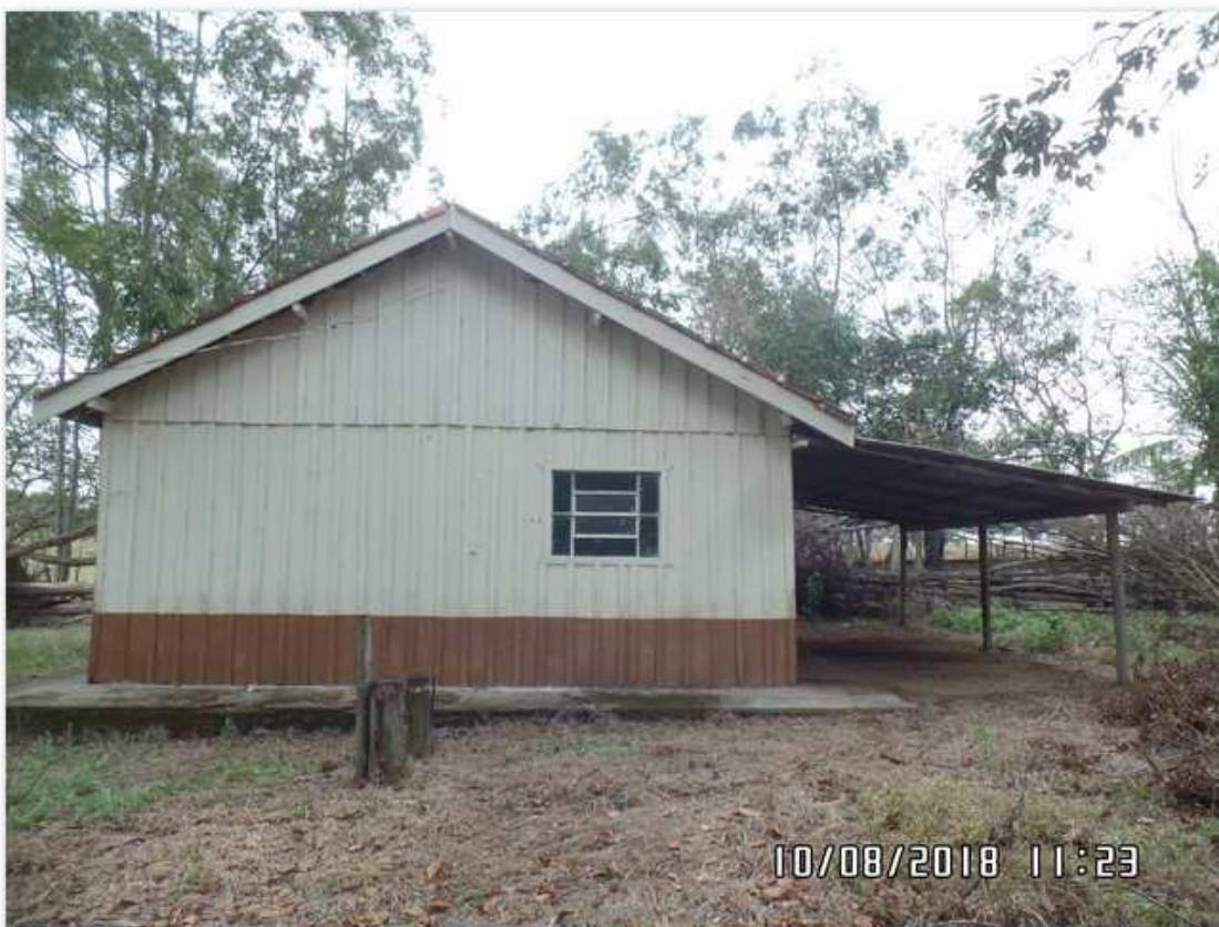
Figura 07: Casa para funcionário.
