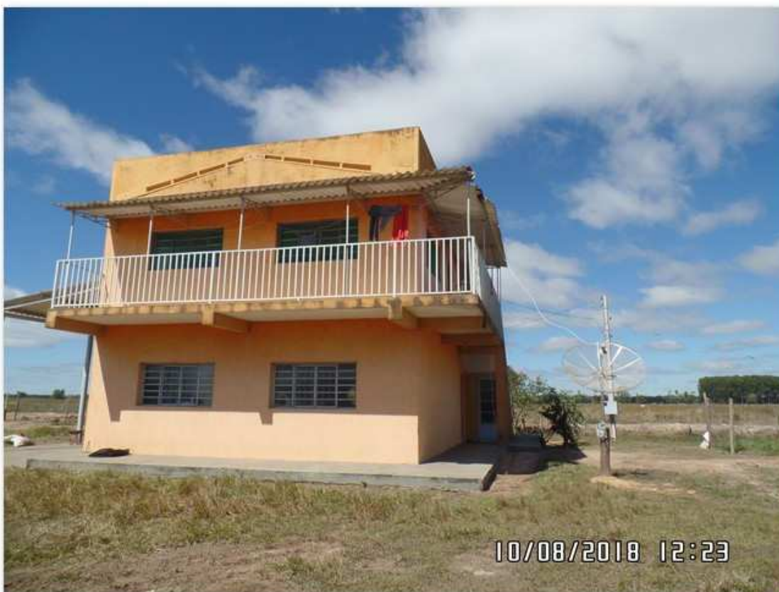
Figura 09: Sobrado feito em Barracão pré-moldado.
